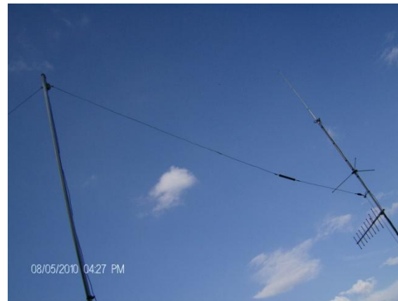
Dipolo 15-40 Metros (9 mts de largo)
